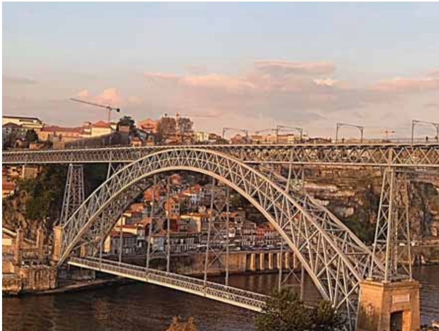
Puente Don Luis I sobre el Duero de Gustave Eiffel, 1886; entre Oporto y Vila Nova de Gaia. Por el nivel inferior discurren el tráfico rodado y los peatones; por el superior la vía férrea mediante una celosía sobre pilares que en su parte central apoya sobre el arco. Foto Ángeles.
