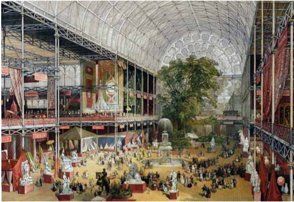
Joseph Paxton. Palacio de Cristal, levantado en Hyde Park, Londres, para albergar la Exposición Universal de 1851, según una litografía de época. Construcción rectangular de tres naves dispuesta en otras tantas alturas, realizada a base de módulos de hierro fundido.
