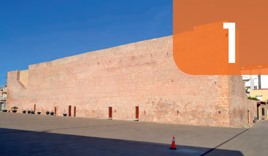
El Hospital, paramento oeste.
