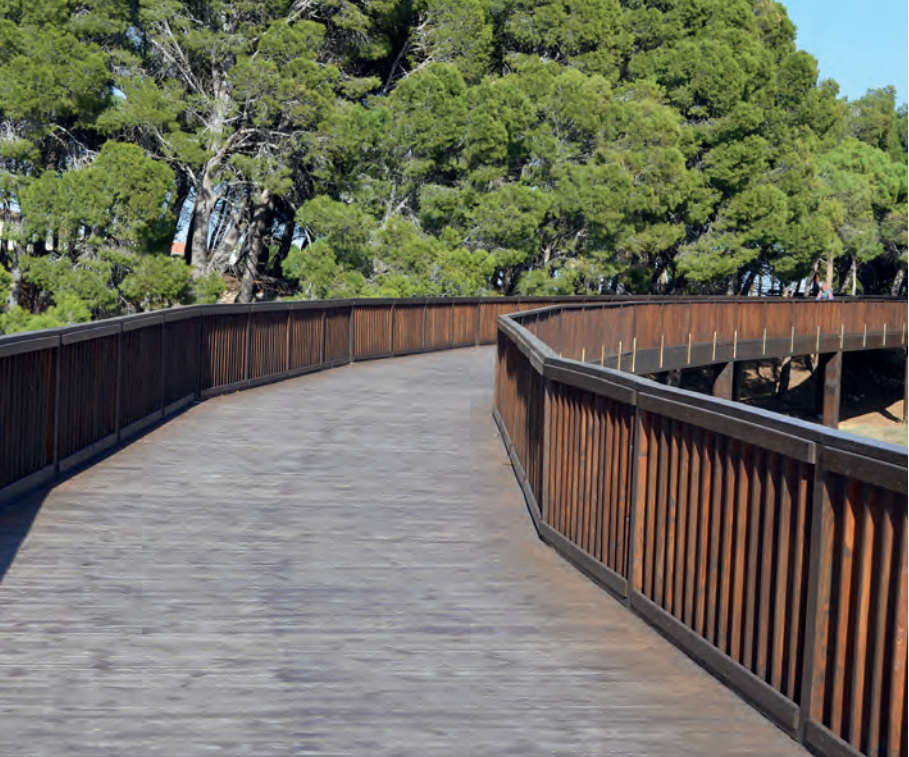
Pasarela de madera en la desembocadura del río Llastres.
