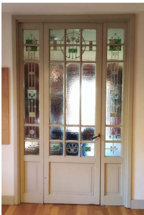
Fig. 4. Puerta con vidriera decorada con esmalte cloisonné realizada por la casa Maumejean. Ejemplo de bien inmueble perteneciente al Palacio del Señorío de Bertiz, Oiategi, Navarra. Guarda su emplazamiento original. 19/12/2018. Imagen: Amaya Sánchez Bakaikoa.
