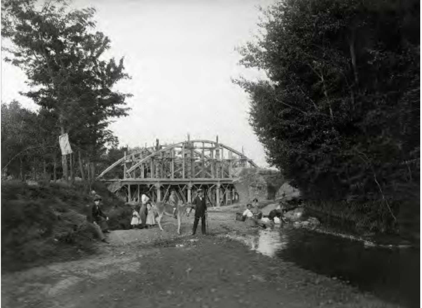
Construcción del puente de San Miguel. Huesca. 1911-1912
