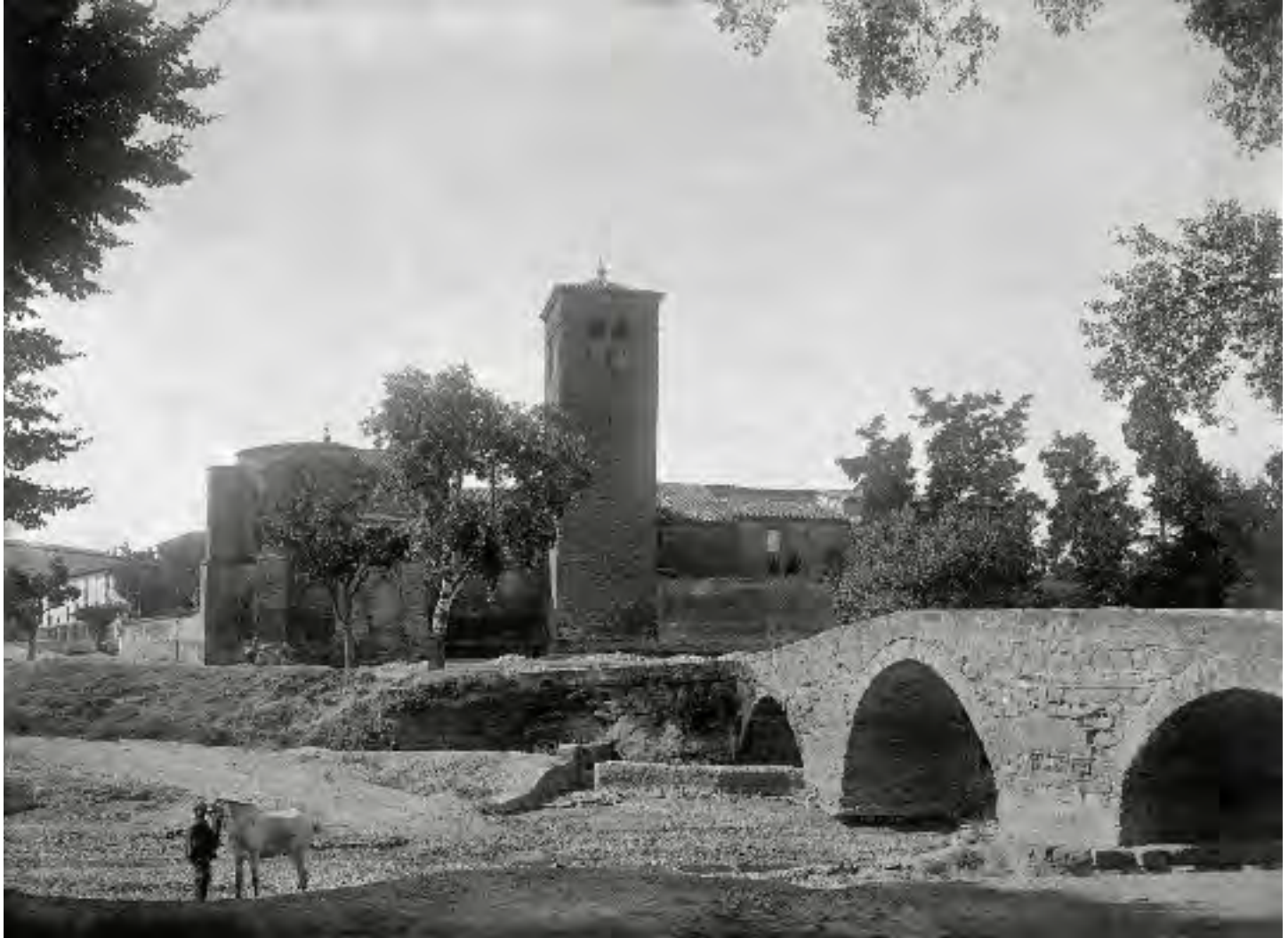
Puente y convento de San Miguel. Huesca. 1910-1912
